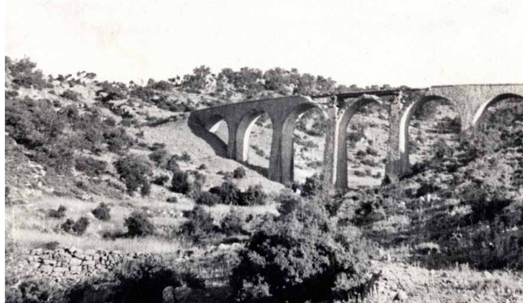
Σ. | Η λίθινη γέφυρα της Μάκρης στο χ.σ. 130+362. Στα κεντρικά τόξα, διακρίνονται τα αποτελέσματα της προσπάθειας ανατίναξης της από τους Γερμανούς ( συλλογή Α. Κουρμπέλη).
